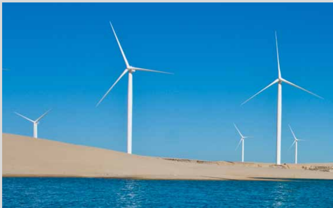
Parque eólico da CPFL Renováveis, Camocim (CE)
