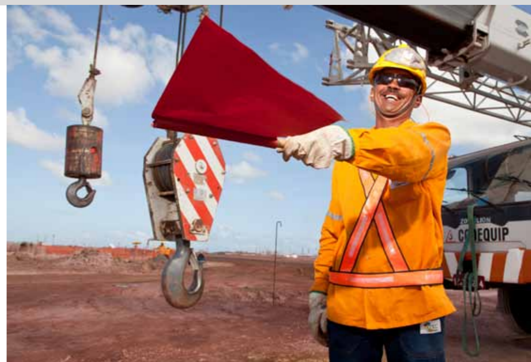
Antonio da Silva, Constructora Camargo Corrêa, Refinería Abreu e Lima, Ipojuca
