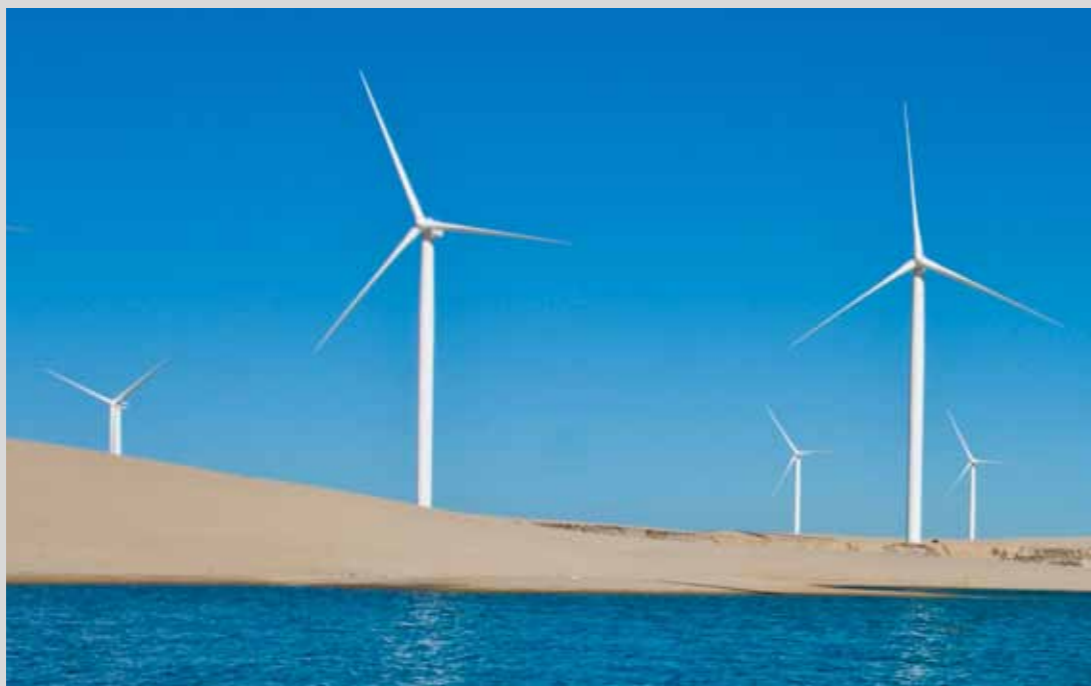
Parque eólico de CPFL Renováveis, Camocim (Ceará)
