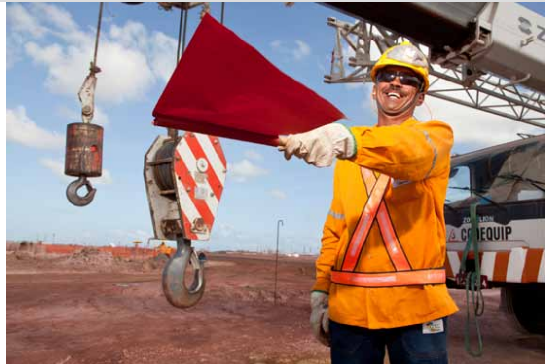
Antonio da Silva, Construtora Camargo Corrêa, Abreu e Lima Refinery, Ipojuca (PE)
